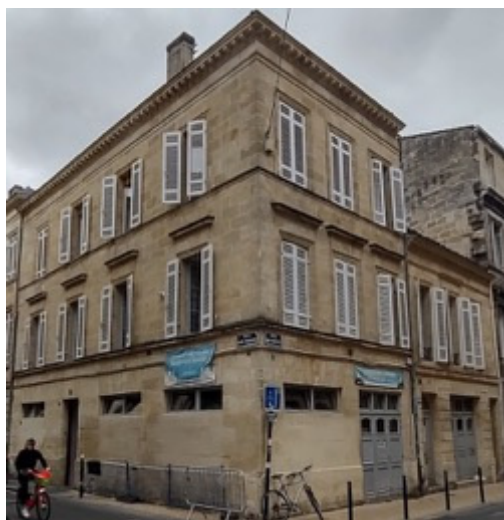
Рис. 5. Мечеть Нур эль Мохамеди (Nour el-Mohammadi) в районе Сен-Мишель, Бордо. Молитвенная комната находится на первом этаже здания на углу улиц Rue Saint François и Rue des Menuts
